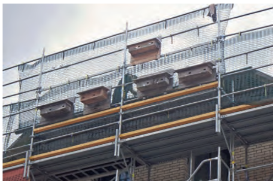
Nistkästen am Baugerüst als Übergangslösung.
